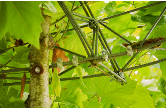
Bei der Baubotanik werden lebende und nicht lebende Konstruktionselemente so miteinander verbunden, dass sie zu einer pflanzlich-technischen Verbundstruktur verwachsen.
