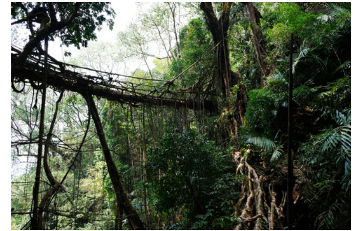
Die lebenden Brücken der Khasi People aus Meghalaya (Indien) entstehen über Generationen. Die Brücken aus den verschlungenen Luftwurzeln des Gummibaums Ficus elastica sind mechanisch äußerst stabil.
