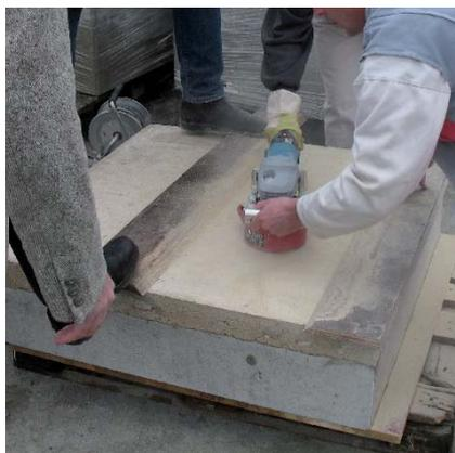
Abb.: 6.35 Stocken von Holzleichtbeton
