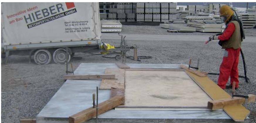
Abb.: 6.36 Sandstrahlen der Musterfläche
