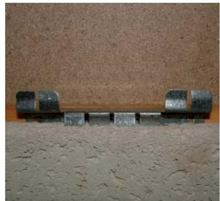
Abb.: 5.41 Haltekralle in Platte eingeschoben
