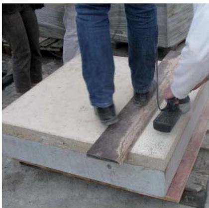
Abb.: 6.34 Schleifen von Holzleichtbeton
