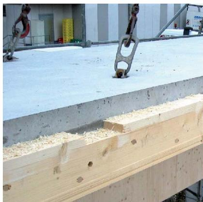
Abb.: 4.4 HBV-Deckensystem Optiholz
