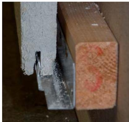
Abb.: 5.40 Detail Haltekralle mit geschlitzter Plattenkante
