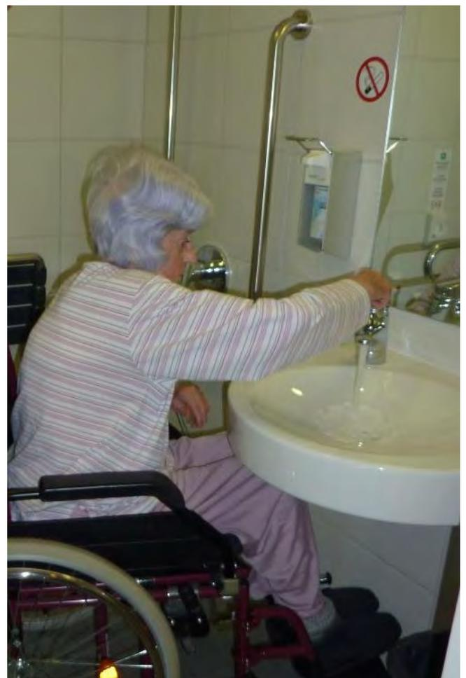
Abb. 70: Einhebelmischer mit längerem Hebel auch bei körperlichen Einschränkungen hilfreich
