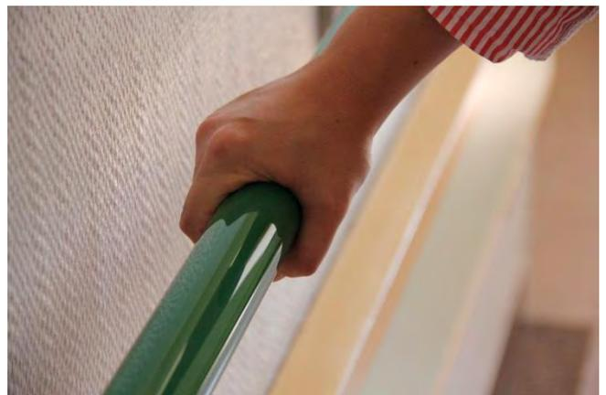
Abb. 80: Kunststoff-Handlauf, 40 mm
