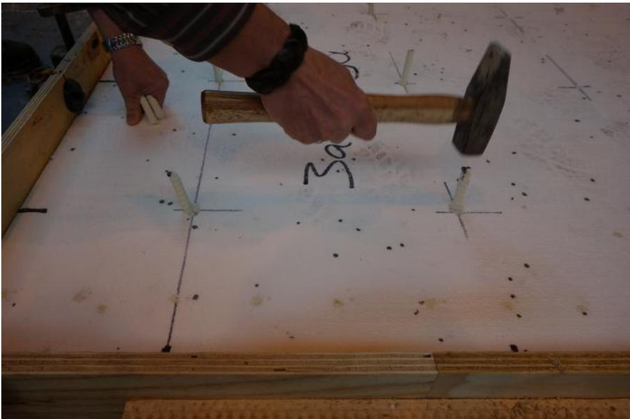
Bild 29: M. Pätzold, Einbringen der GFRK-Stabdübel, 2015
