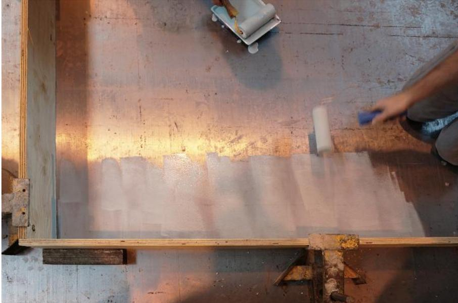
Bild 24: M. Pätzold, Aufbringen des Abbindeverzögerer auf Stahlschaltisch, 2015
