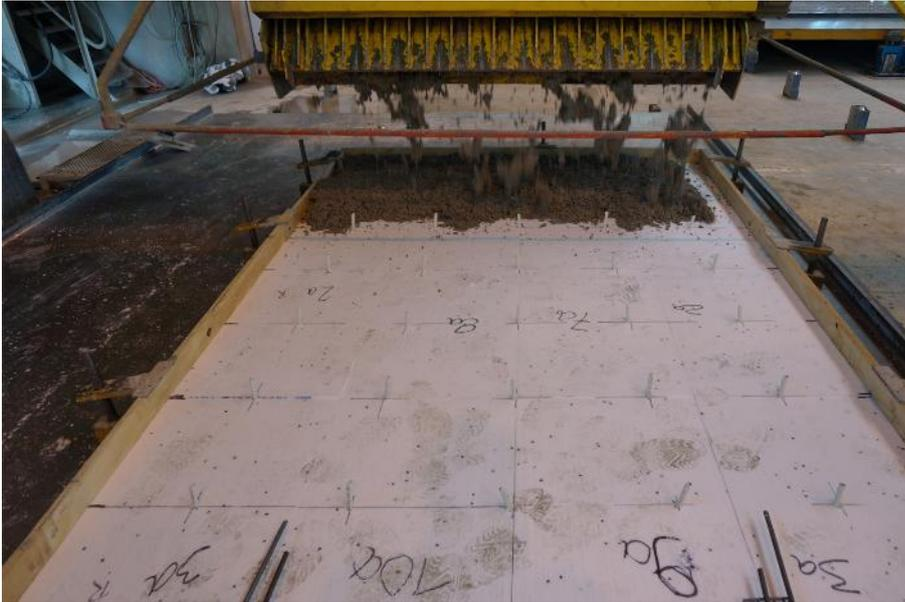
Bild 30: M. Pätzold, Aufbringen Tragschicht mittels Verteileranlage, 2015
