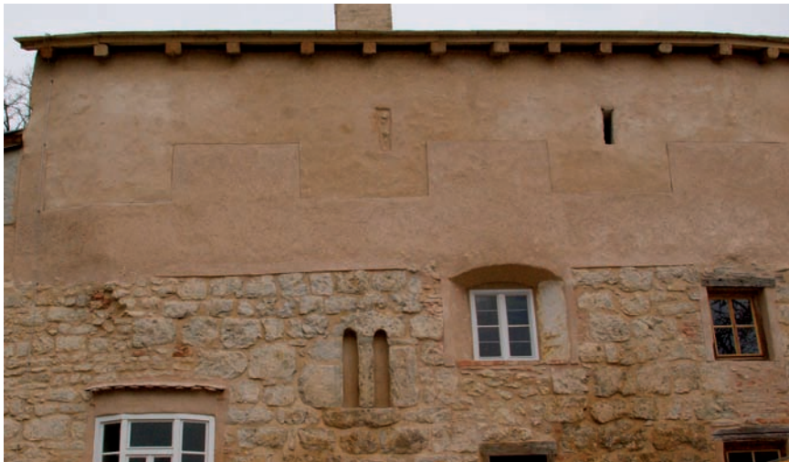
Abb. 4: Instandgesetzte westliche Wehrmauer, der romanische Mauerteil (13. Jh.) wurde nicht verputzt, die im 14. Jh. aufgesetzten Zinnen erhielten einen erhabeneren Putz.
