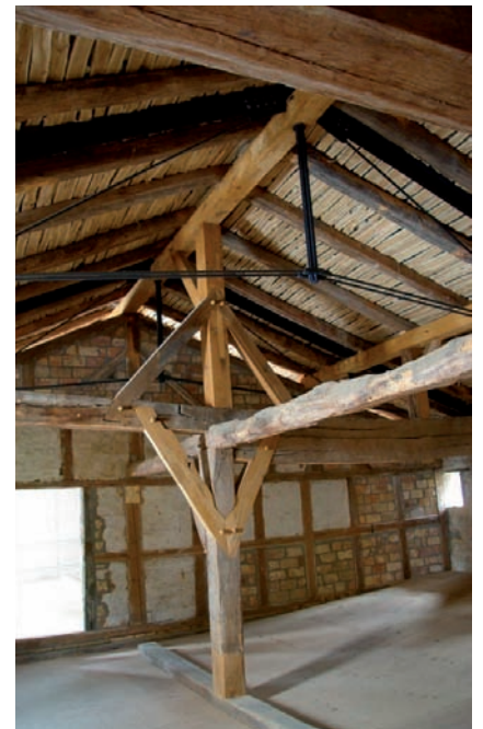
Abb. 23: Der Stahlbinder ordnet sich dem Bestand unter.
