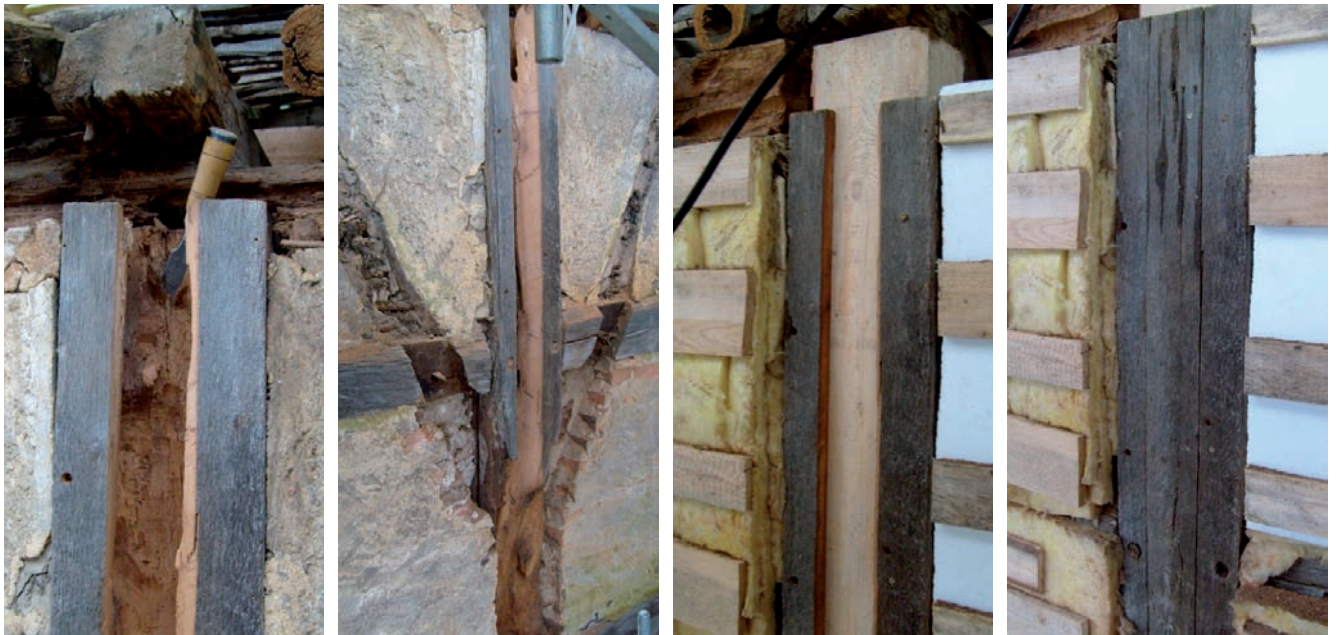
Abb. 16: Ablauf der Fachwerkinstandsetzung: Der im Innern geschädigte Ständer wird außenseitig aufgeschnitten, das zerstörte Holz herausgenommen und durch ein neues Holz ersetzt (Bild 16.3). Anschließend wird das äußere Holzstück wieder als Vierung eingesetzt..
