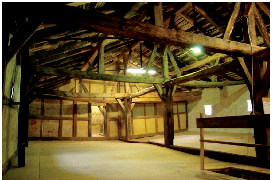
Abb. 21: Dach nach der Instandsetzung.
