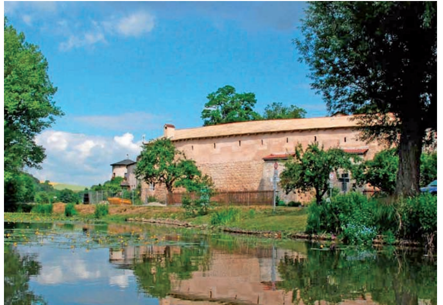
Abb. 1: Südansicht. Blick von der Altmühl auf die instandgesetzte Ringmauer.
