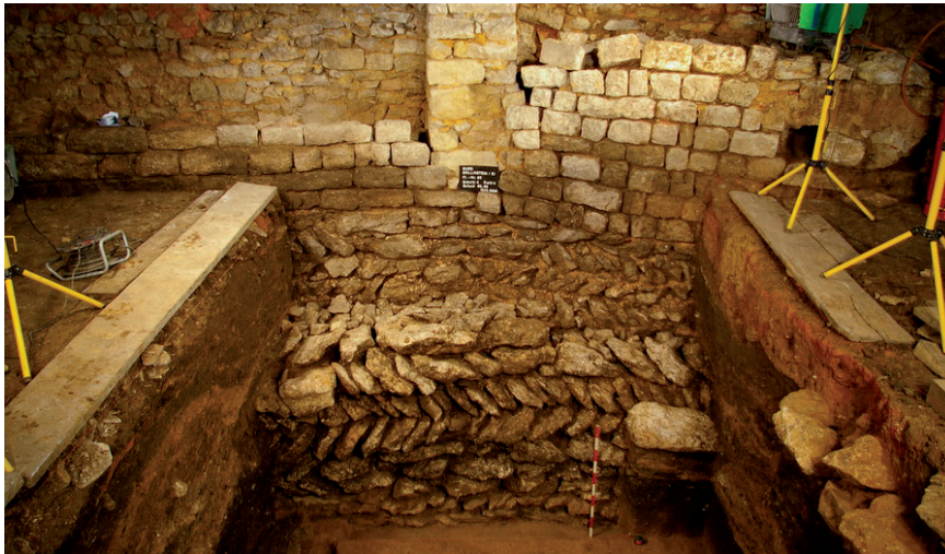
Abb. 3: Archäologischer Schnitt 4 im Ostteil mit opus spicatum (lat. „Ährenwerk“ von lat. spica = Ähre).
