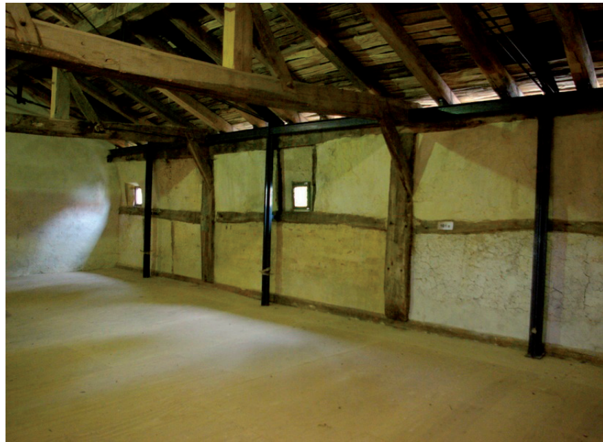
Abb. 15: Innenseitig wurde eine Subsidiärkonstruktion angeordnet.
