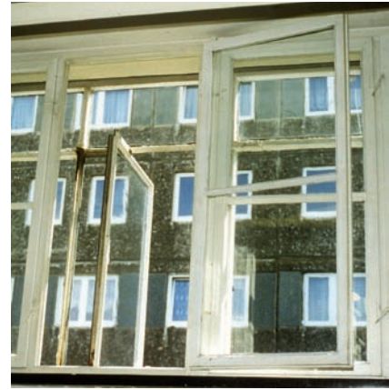
Abb. 14,15: einfach verglaste Fensterbänder im Verwaltungstrakt
