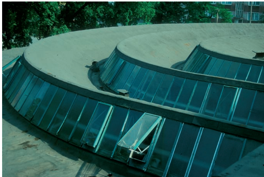
Abb. 22: Klappfenster in den Sheddächern, Öffnungsmechanismus
