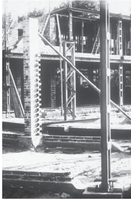
Abb. 8: Ummauerte Eisenskelettkonstruktion des Rundbaus
