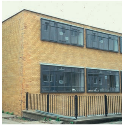
Abb. 14,15: einfach verglaste Fensterbänder im Verwaltungstrakt
