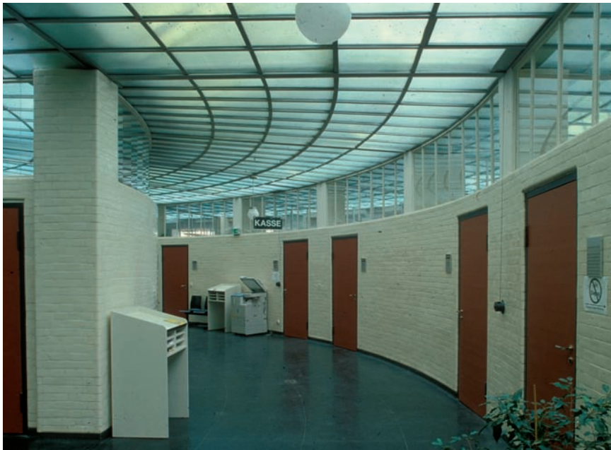
Abb. 10: Innenraum, Flur mit gefliesten Wänden, Terrazzoboden und Lichtdecke aus Prismenglas
