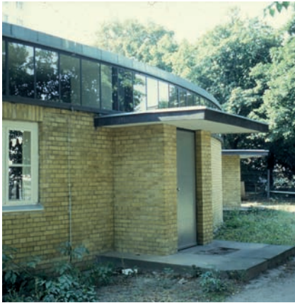
Abb. 13: Außenansicht des Rundbaus mit Oberlichtfenstern in den Warteräumen
