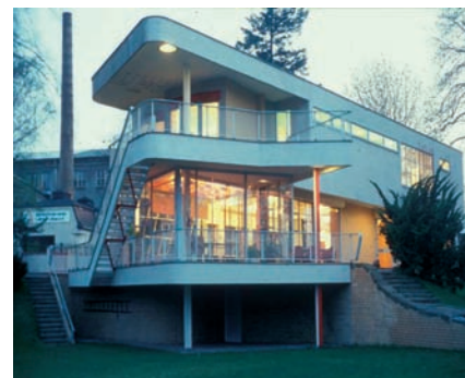
Abb. 2: Haus Schminke von Hans Scharoun 1931/33, Gartenansicht
