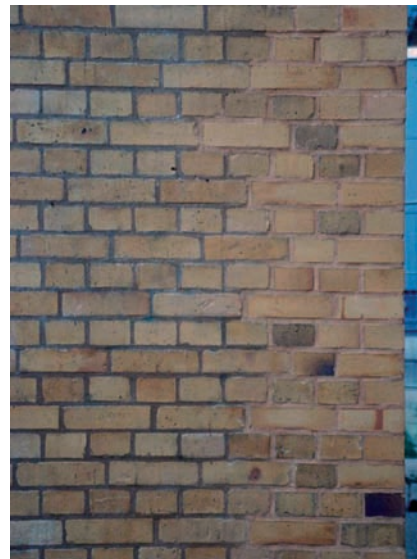
Abb. 12: Reparatur des geöffneten Mauerwerks mit nachgebrannten Klinkern
