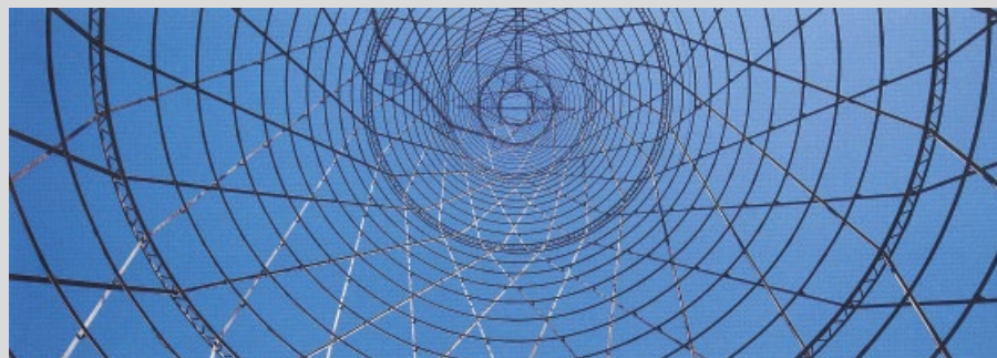
Blick in das Inneres des NiGES-Turmes (S. 11)
