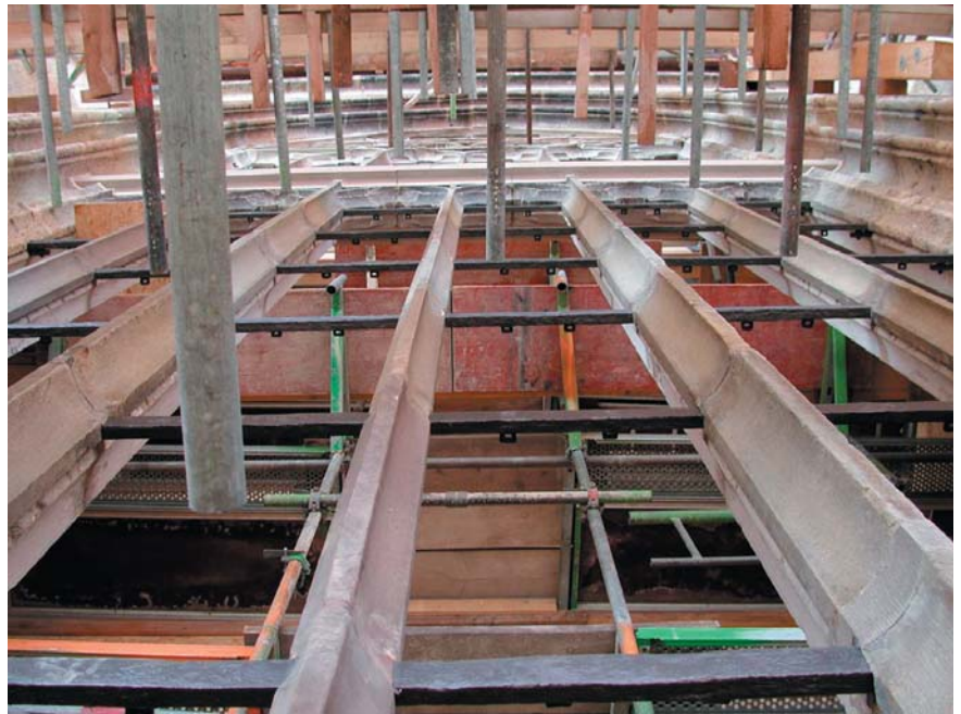
Abb.28: Stäbe aus Sandstein und Stabeisen nach der Instandsetzung
