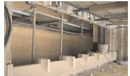
Abb.14: Horizontaler Riegel. Der obere Teil des Riegels musste durch verwitterungsbeständigeren Sandstein ersetzt werden
