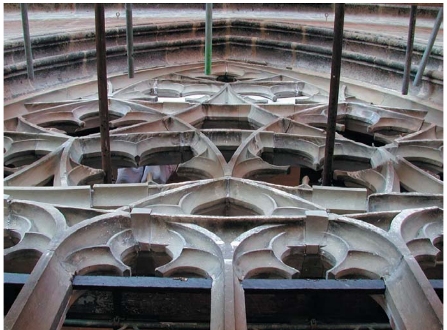
Abb.27: Instandgesetztes Maßwerk. Die eingesetzten neuen Passstücke werden noch angearbeitet.
