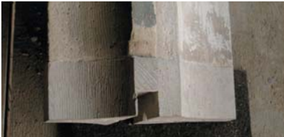
Abb. 17: Instandsetzung mit neuem Passstück
