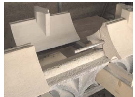
Abb.15: Horizontaler Riegel. Im neuen oberen Teil wird der Zuganker geführt
