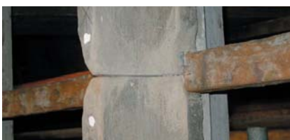
Abb. 19: Ingesägt und nachverbleite Fuge
