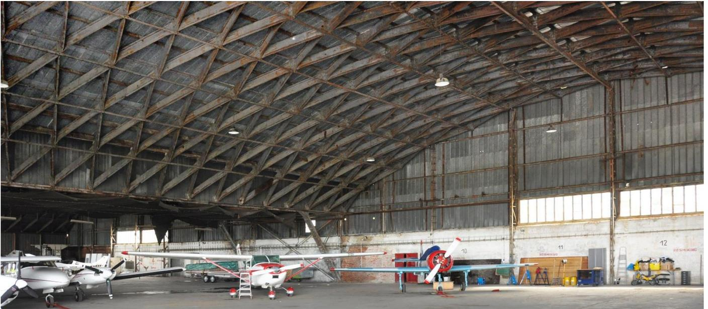
Abb. 1: Blick in die Stahllamellenkonstruktion der Junkershallen, Oberschleißheim
