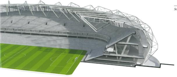
endet in einem Druckring. Hier schließt das konstruktiv unabhängige Tragsystem des Innendaches an. Das Hauptdachtragwerk trägt das Kuppelsystem aus 32 Radialhauptträgern und 8 Meridianringen und wird durch spiralförmig angeordnete Diagonalen ausgesteift.
