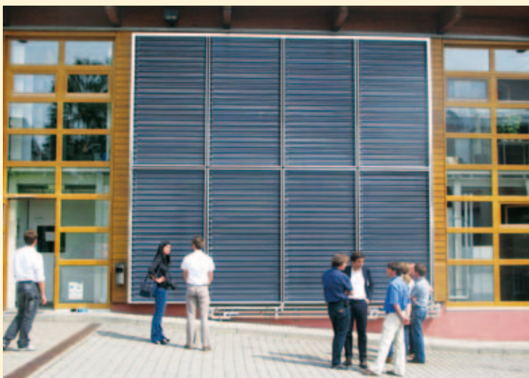
Abb. 4 Pilotanlage: Die Testfassade wurde in Langensteinbach bei Karlsbad an einem Betriebsgebäude der Firma Ritter Energie- und Umwelttechnik installiert. Quelle: Universität Stuttgart, IBK 2
