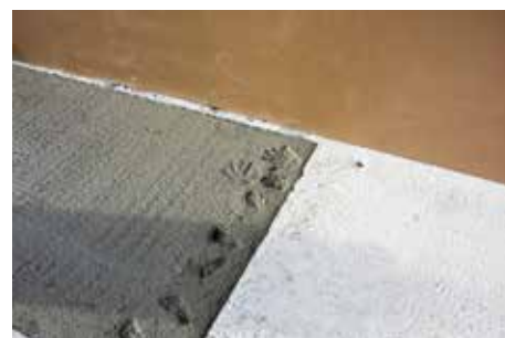
Abb. 3: Grundstein im Fundament
