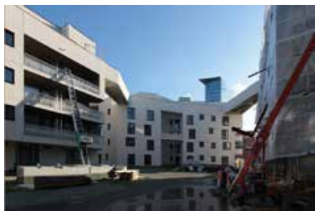
Abb. 13: Baustelle bei Abschluss der Fassadenarbeiten (Januar 2016)
