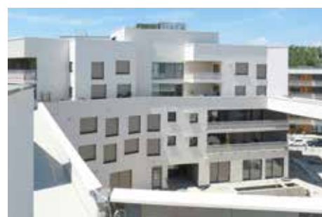
Abb. 70: Geschlossener Sonnenschutz (September 2016)
