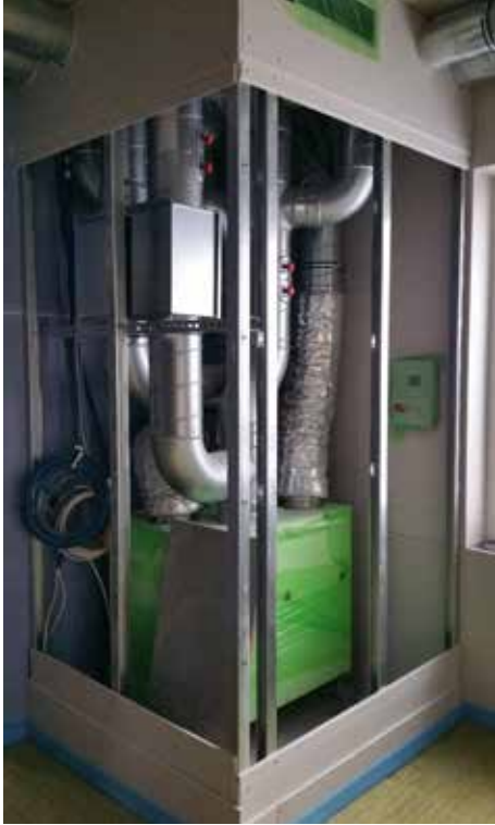
Abb. 48: Installationsraum Clusterlüftung
