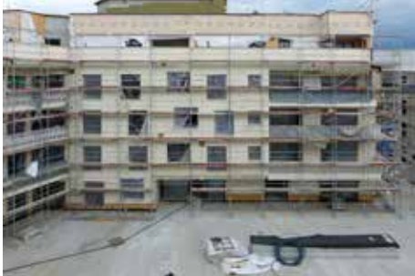
Abb. 10: Baustellenstand zum Richtfest am 18.09.2015
