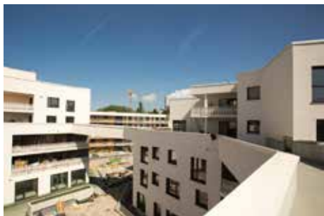
Abb. 73: Dorfplatz und Brücken (September 2016)
