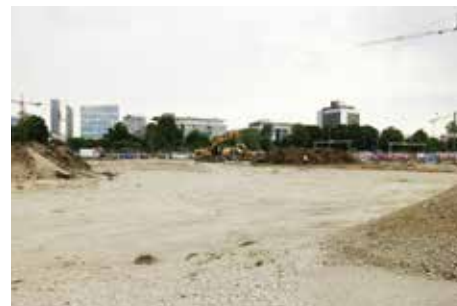
Abb. 2: Baugrube bei Baubeginn 2014
