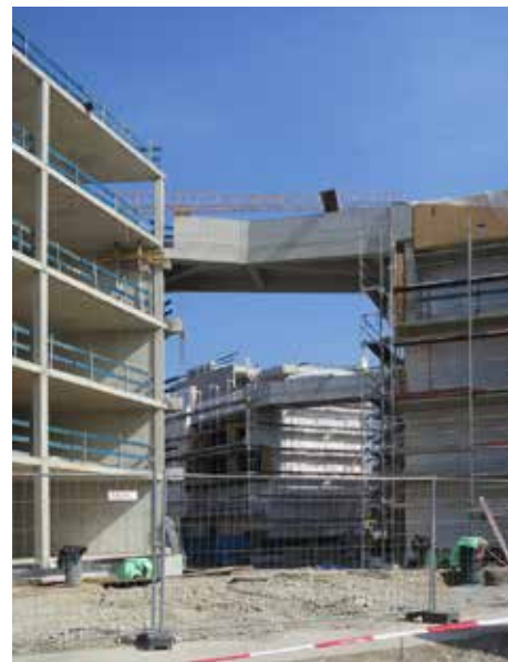
Abb. 6: Eingehängte Brücken zwischen den Gebäuden (März 2015)
