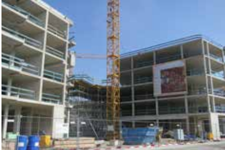
Abb. 5: Stahlbetonskelett (März 2015)
