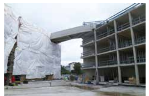
Abb. 9: Rohbau vor Anbringung der Fassade (Juni 2015)
