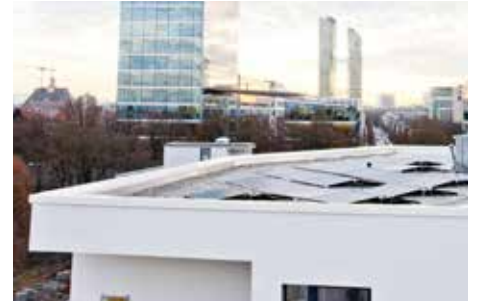
Abb. 40: PV-Anlage auf dem Dach des Hauses Australien
