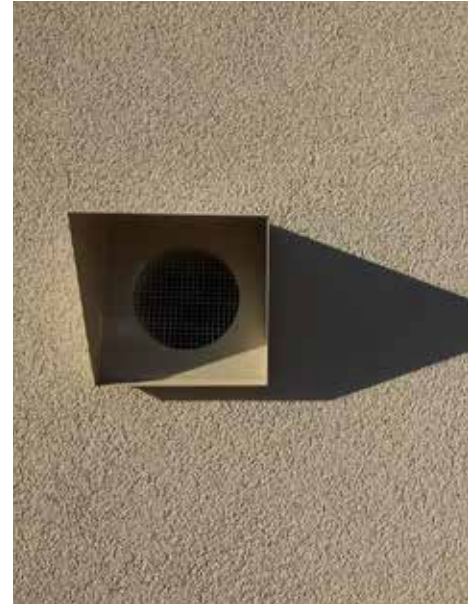
Abb. 46: Lüftungsöffnung an der Fassade
