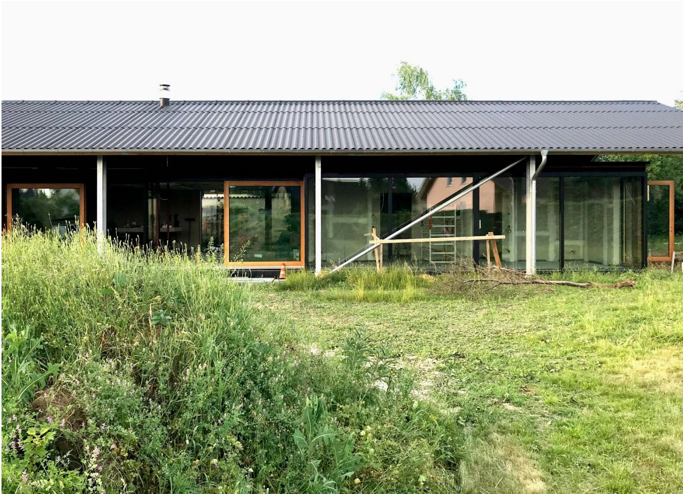
Summacumfemmer Architekten: „Haus B“ bei Dresden
